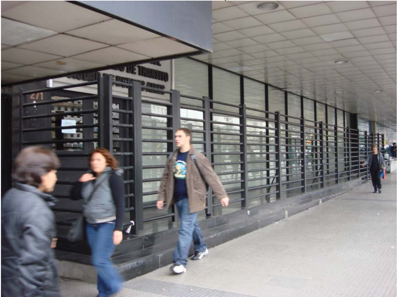
Foto N° 4 – Vista del frente del edificio desde la calle Sarmiento bajo la marquesina donde se puede observar el frente enrejado del Comando de Control Centralizado de tránsito de la Ciudad de Buenos Aires que no tiene atención al público desde la planta baja.
