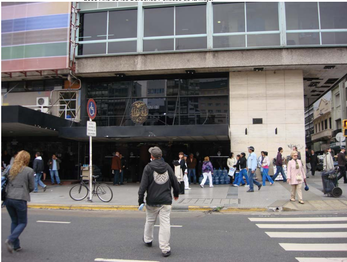
Foto N° 1 – Vista del acceso al Organismo por la calle Carlos Pellegrini, en la misma se puede observar la planta baja con dos niveles. El público debe usar la escalera (para subir y bajar) pues los ascensores que se usan también para acceder a los 7 pisos restantes no cubren las necesidades del acceso al 1º piso.
