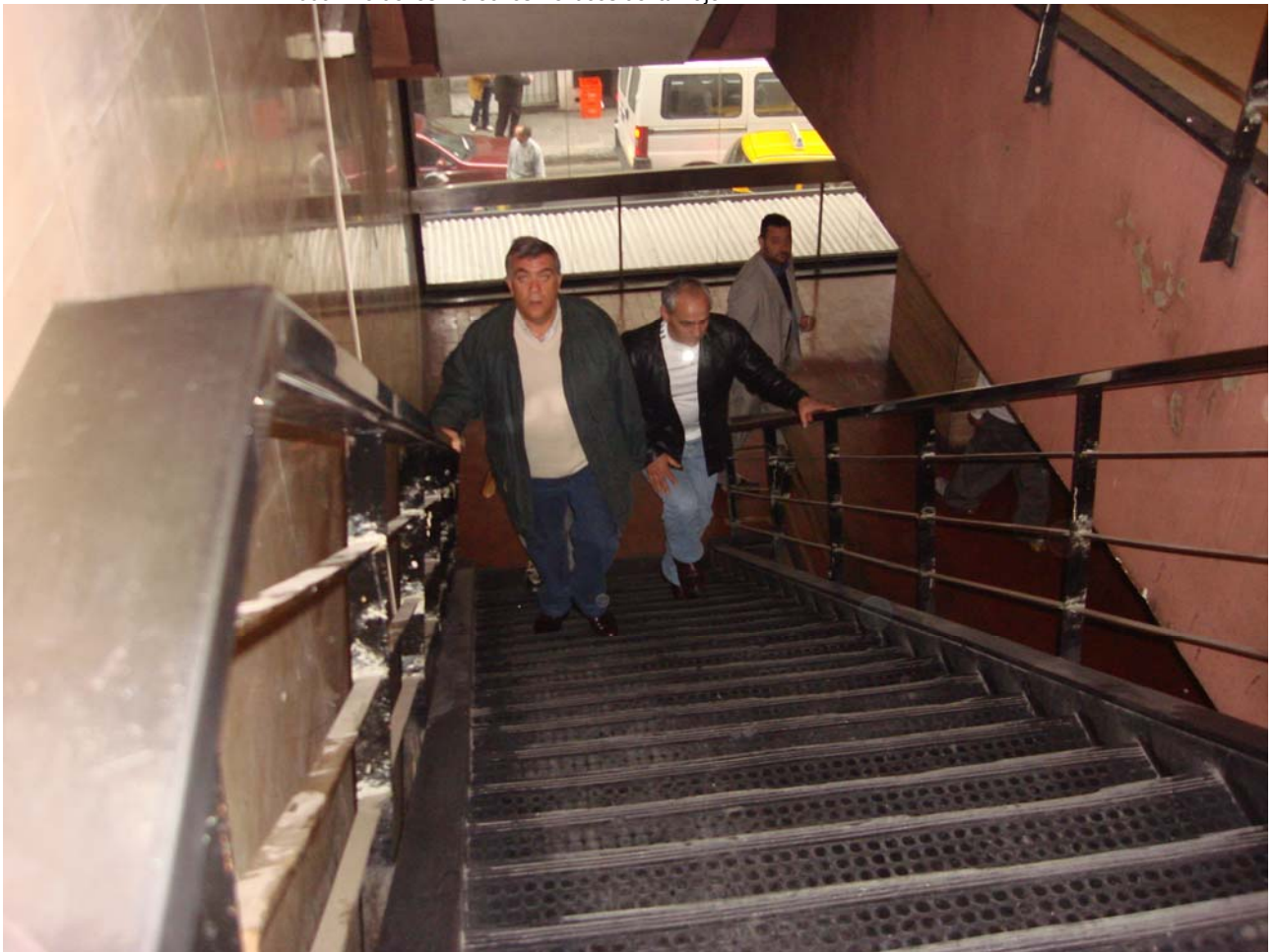
Foto N° 7 – Vista de la escalera desde el primer piso hacia el descanso del entrepiso (a las 10 hs.).
